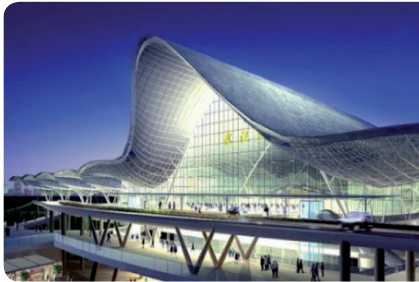
▲ 武汉高铁火车站（三星级绿色建筑，采用热泵技术和太阳能发电技术提供所需能源）
