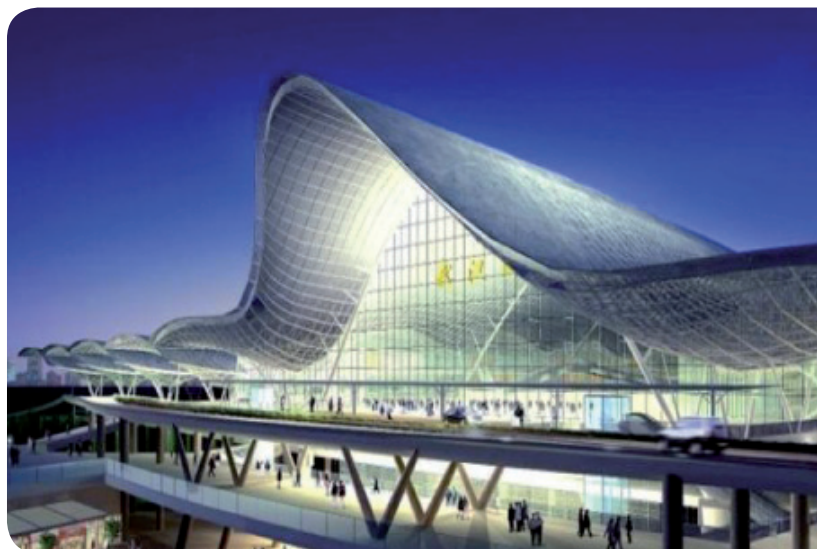
▲ La Gare du TGV de Wuhan bâtiment vert trois étoiles utilisant la technique de pompe à chaleur géothermique et des panneaux solaires pour produire de l'électricité
