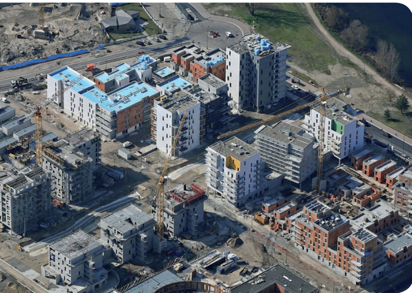
▲ construction de l'éco-quartier Ginko à Bordeaux.
