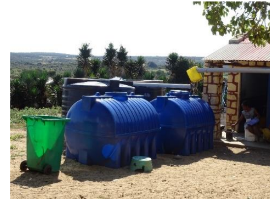
Bassin de stockage CSB
