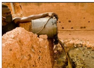
Vidangeur manuel sans protection adéquat rejetant les boues dans la concession (Photo réseau Projection)
