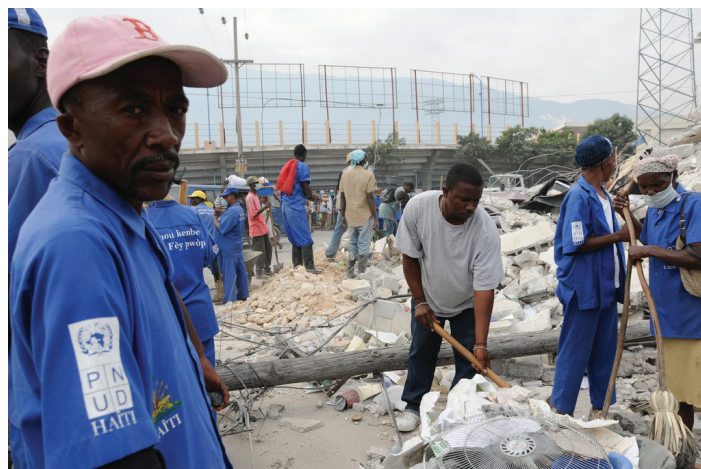
Le programme « Argent contre travail » mis en œuvre par le PNUD. Des travailleurs retirant les débris des rues de Martissant, une banlieue de Port-au-Prince située à proximité de l'épicentre du séisme. Photo : Adam Rogers / PNUD
